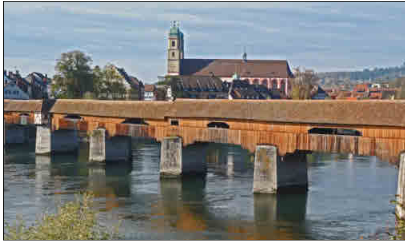
Die alte Holzbrücke ist für viele Menschen in der Region mehr als eine Verbindung von Bad Säckingen nach Stein in der Schweiz. FOTO: KARL BRAUN
